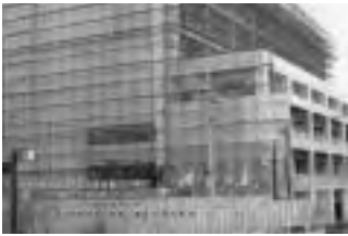
建設中の光が丘区民センター (昭和62年頃)
