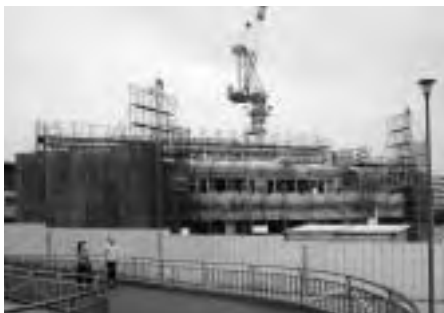
建設中の光が丘中央図書館（平成6年）
